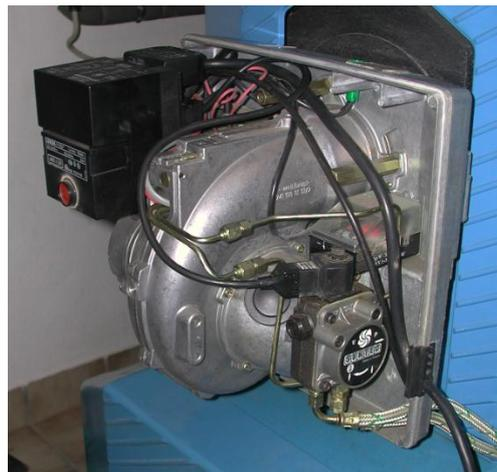
**Schritt 3 Abziehen des 7 – poligen Verbindungsstecker Kessel – Brenner**
