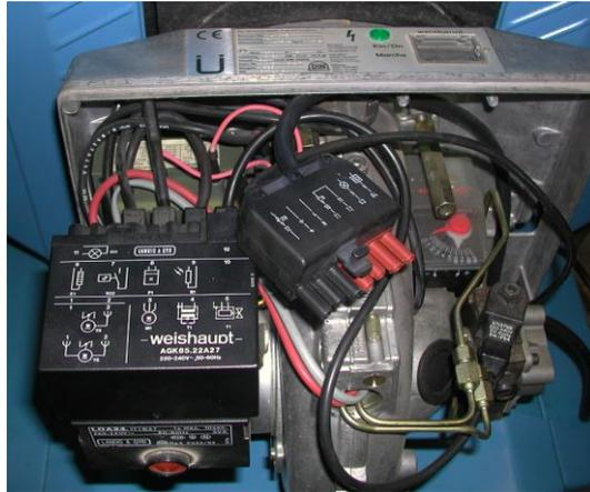
**Schritt 4 Einstecken des Steckers des Betriebsstundenzählers**
