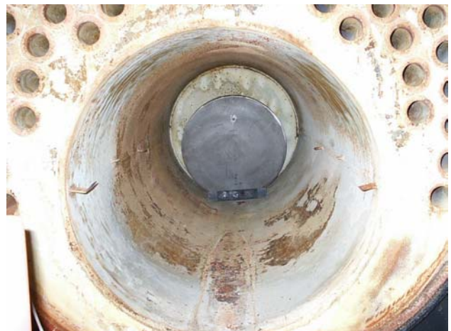
Brennkammer mit EcoTherm2000 - Einsatz
